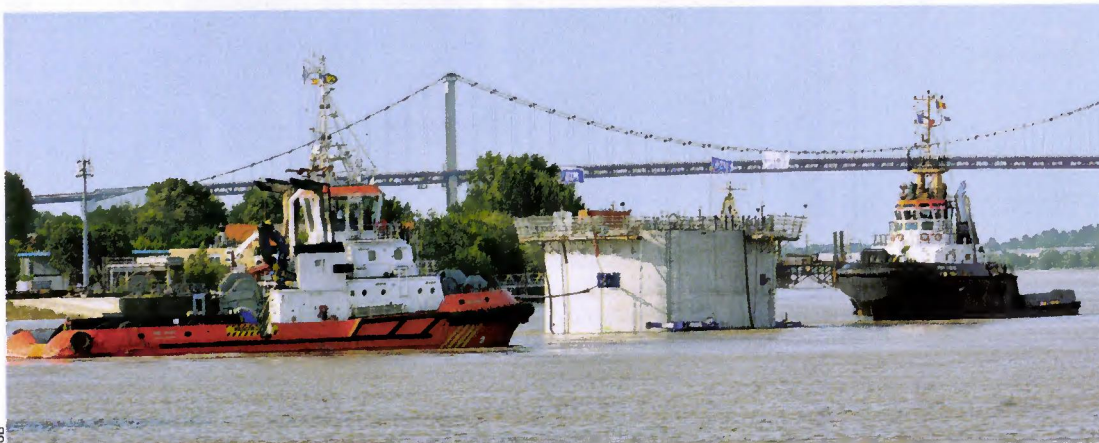
Pas moins de trois remorqueurs ont acheminé, depuis le radoub de Bassens vers la rive droite bordelaise, les trois éléments préfabriqués dont l'embase du pont. Ici, le premier îlot de protection de 18 m de diamètre.
