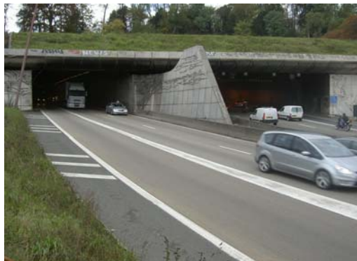
Tunnel Saint Cloud – Tête Est
