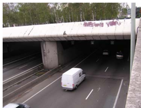
Tranchée couverte Ambroise Paré – Tête Est
